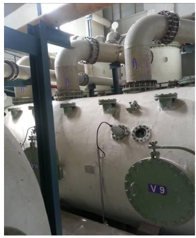
蒸发室、二次蒸汽管、预加热器
