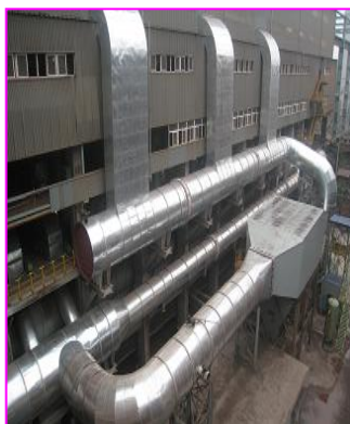
宁钢486m 2 烧结机废气循环示范工程（2013.05投运）
