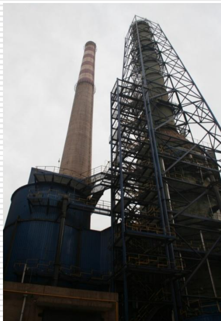
图1 双循环双塔脱硫及钢支架吊挂湿烟囱技术装备
