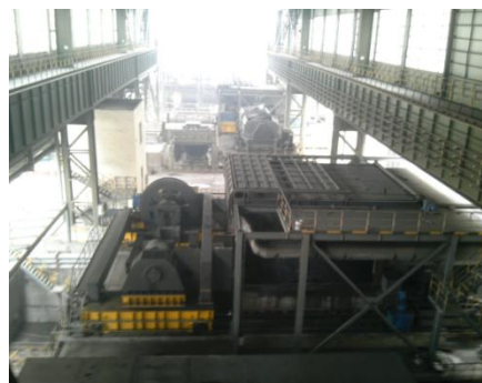
济源工程一生产现场
