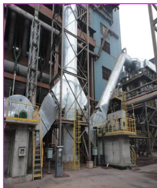
不锈钢132m 2 烧结机废气循环中试装置（2012.10投运）
